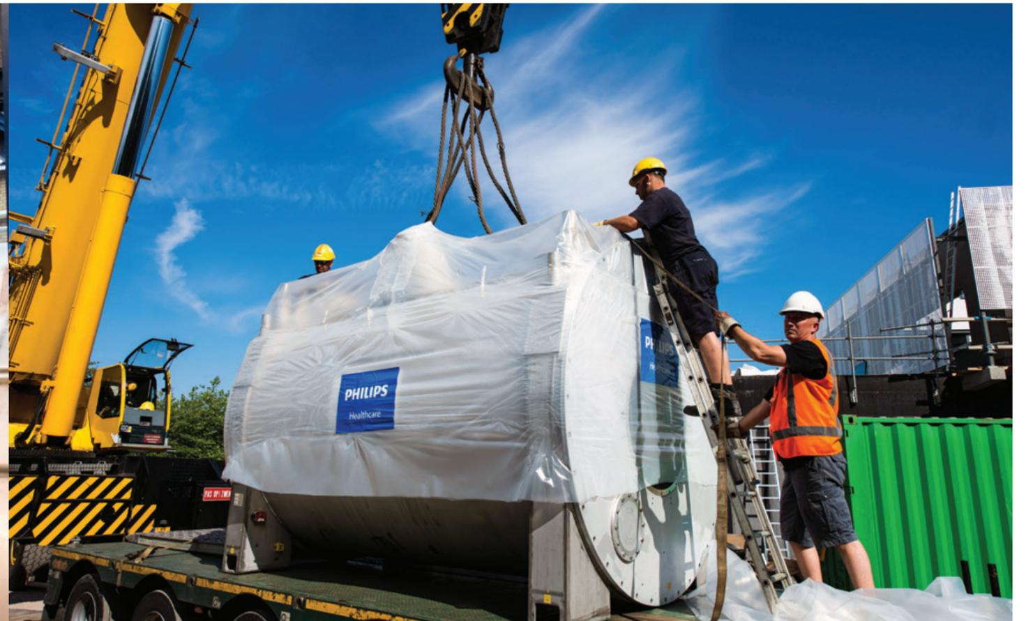
Таким образом транспортируют один из самых мощных МРТ, аппарат 7 Tesla весом 32 тонны
